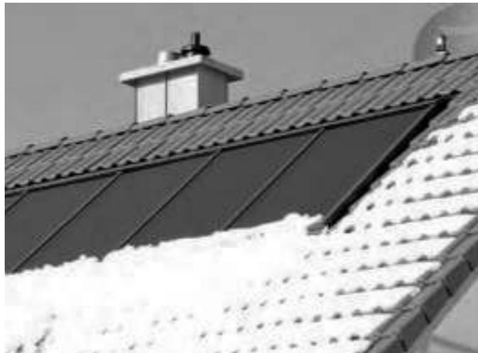
**Alarmfall:** Bedeckt Schnee die Photovoltaikmodule, führt das zu Ertragsausfällen.
